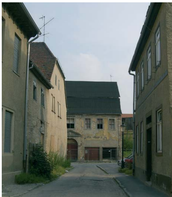
↑ Straßenzüge in Naumburg warten auf die Sanierung und die Schließung der derzeit noch als Parkplatz genutzten Lücken. Foto: Katharina Kipp
