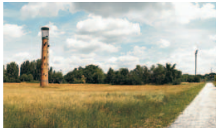
Am Schornstein des alten Heizhauses wurden verschiedene Nisthilfen angebracht.
