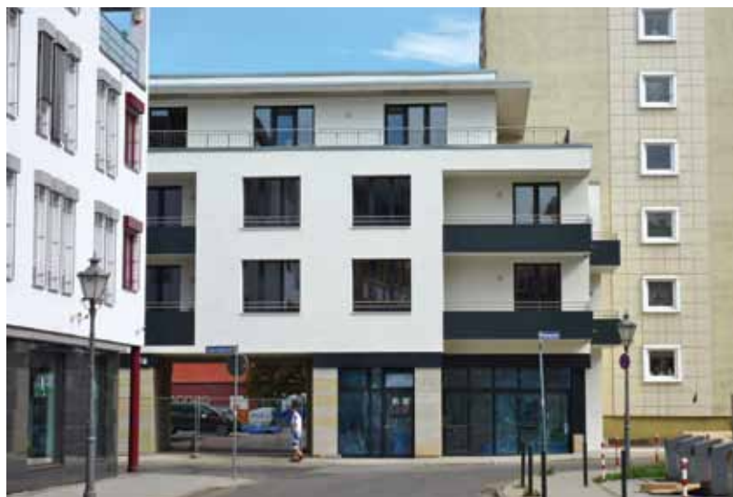
Bild unten: Neubau eines Wohn- und Geschäftshauses in Passivhaus-Standard, 2010, Magdeburg, Regierungsstraße.
