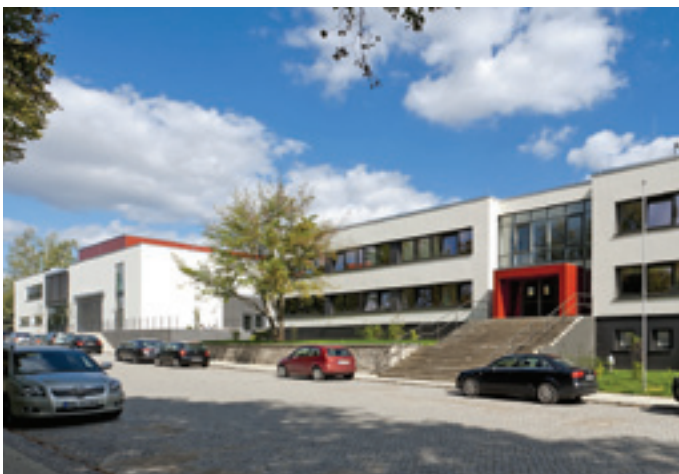
Haus 2 - Verwaltungsgebäude der Fachhochschulleitung
