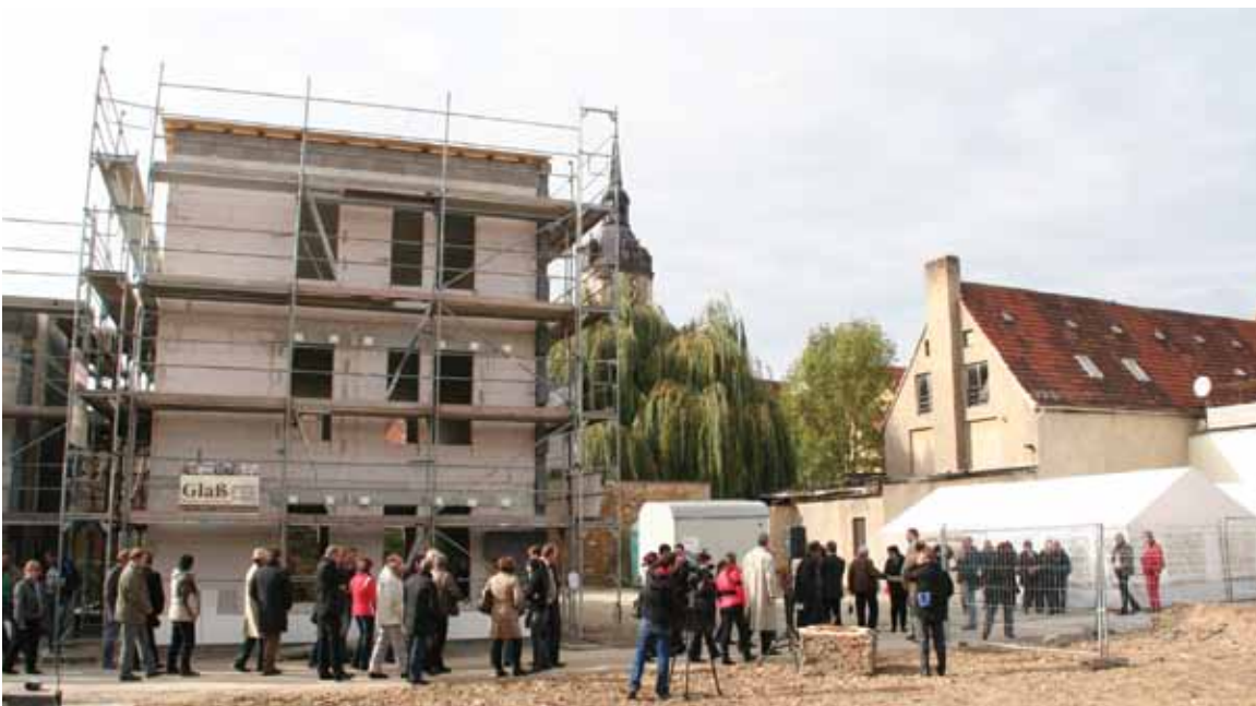
Einweihung des Rohbaus in der Jakobsgasse, Naumburg Foto: Petra Heise
