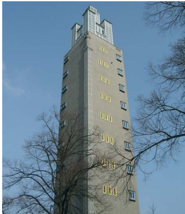
↑ Aussichtsturm im Magdeburger Stadtpark Rothehorn 1926/27 nach Plänen des Architekten Prof. Albinmüller errichtet. Generalsanierung 2006 Kossel, Simon und Partner, Magdeburg
