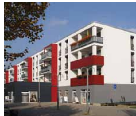
... und nach dem Umbau | Fotos: Büro Brezinski
