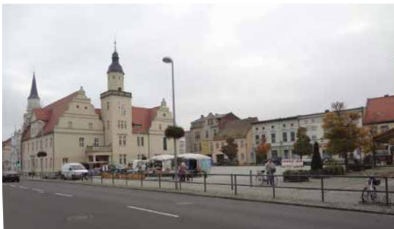
Ungewohnt freier Blick auf das kürzlich sanierte Rathaus in Coswig (Anhalt): Der kaum abbreiende Verkehr auf der B 187 zerschneidet den Ort, hier sind Lösungen gesucht.
