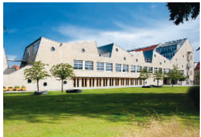
Bildungszentrum Bestehornpark in Aschersleben
