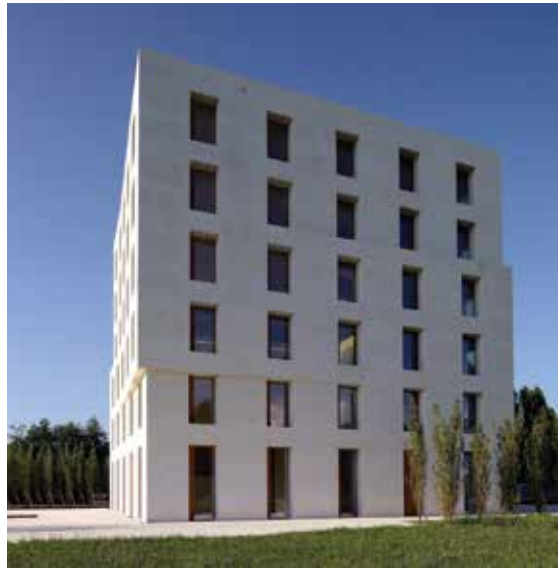
Das Haus der Zukunft? – Bürogebäude „2226“ von Baumschlager Eberle Architekten, Lustenau (Österreich).
