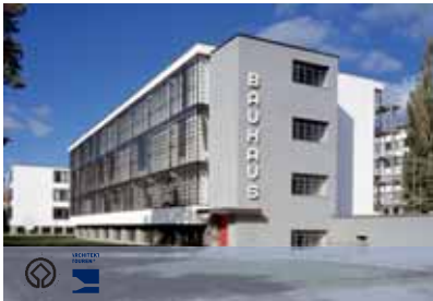
Das Bauhaus in Dessau-Roßlau ist eine Ikone der Moderne | The Bauhaus in Dessau-Roßlau is an icon of the modern style
